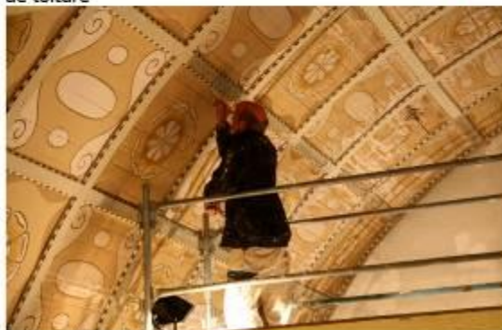
la restauration du plafond
