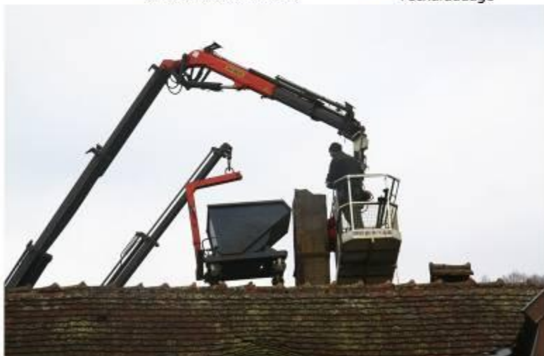
démontage de la cheminée
